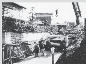
従来工法（クレーン敷設）
