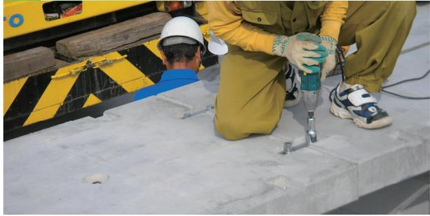
連結プレートを用いて本体製品相互を連結します。インパクトレンチがあると施工が容易です。
