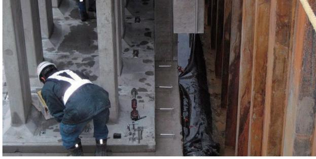
ハニカムボックスⅡ (H=2.0m以下) のパネルを据え付けする前に、写真のように本体の底板に連結ボルトを仮固定して下さい。
