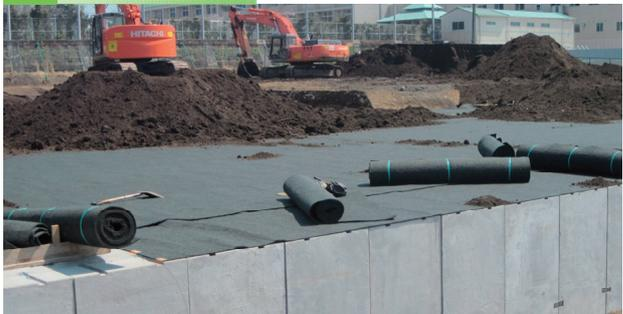
製品上面に吸出防止シートを敷き、土を埋戻します。
