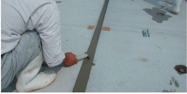
ハニカムボックスⅡ一般用の本体天端にはスリット状の窪みがありますので、バックアップ材を設置しコンクリート又はモルタルで間詰めをして下さい。
