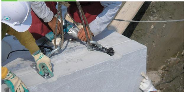
本体とパネル及びパネル同士を連結します。仮止めをするまでは吊金具を外さないようにして下さい。
