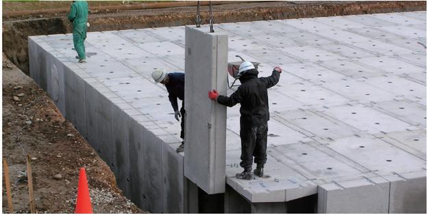
漏水防止用の止水パッキンを貼り付け、パネル製品を据え付けます。
