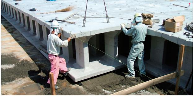
敷モルタルを用いて高さの調整を行いながら、本体製品を据え付けます。
